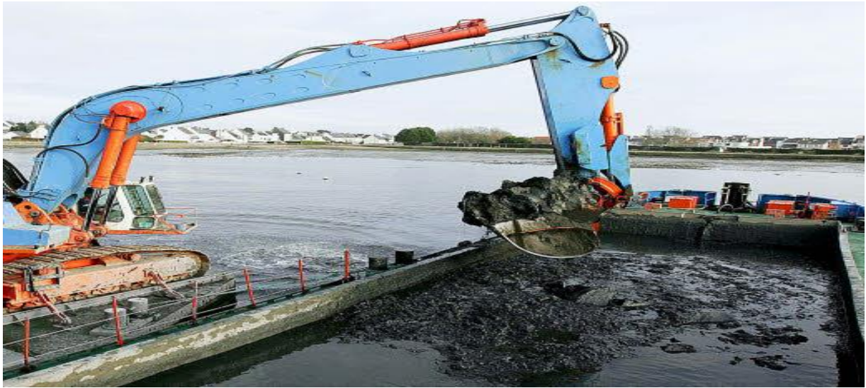
Figure I.3: Dragage mécanique (Source : Tribout. C, 2010).
