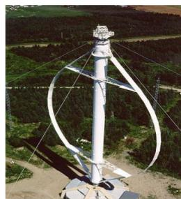
Figure 1.5 : L'éolienne de Darrieus
