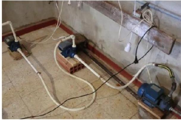
**Figure III.7 :** Installation des trois pompes.
