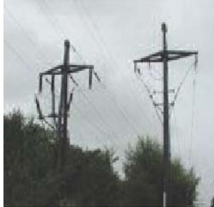
Figure. I.4 : photo d'une ligne à haute tension sur pylônes en béton
