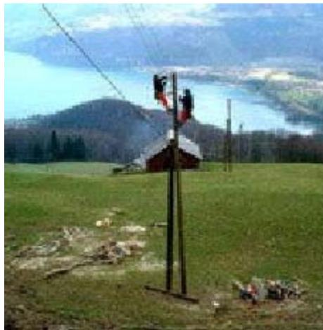
Figure. I.5 : photo d'une ligne à moyenne tension sur poteaux en bois
