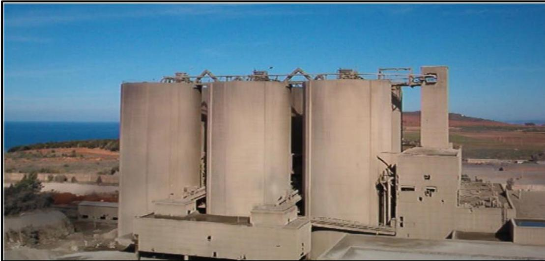
**Photo (IV.9) :** Les silos de stockage de ciment
