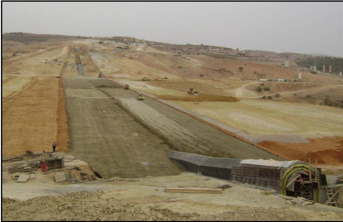
**Photo (III.1):** Noyau centrale d'argile, cas du barrage de Kerrada
