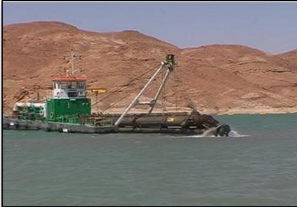
**Photo (II.11) :** Dragage activant dans la retenue du barrage Foug-El-Gherza (Biskra)
