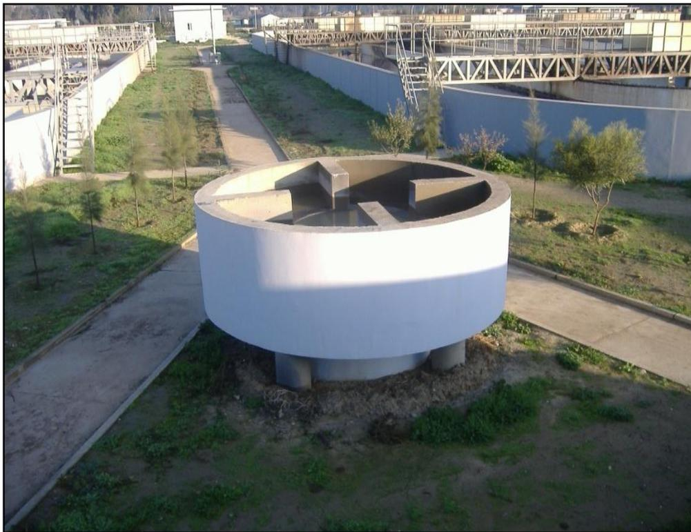
**Figure (I.7) : Puits de distribution [44]**
