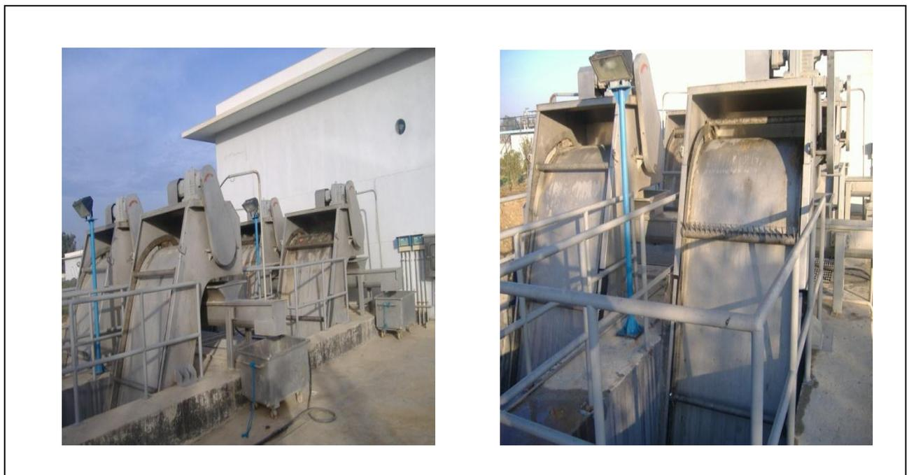
**Figure (I.4) : Quatre Dégrilleurs [44]**
