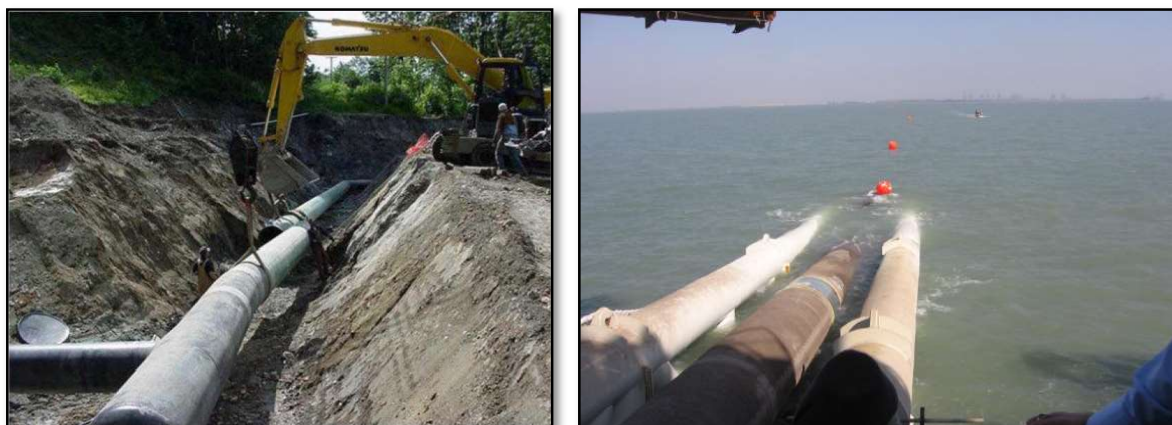
Fig.1.5. Exemple de conduite et de pipeline enterrés (Seguini, 2016).
