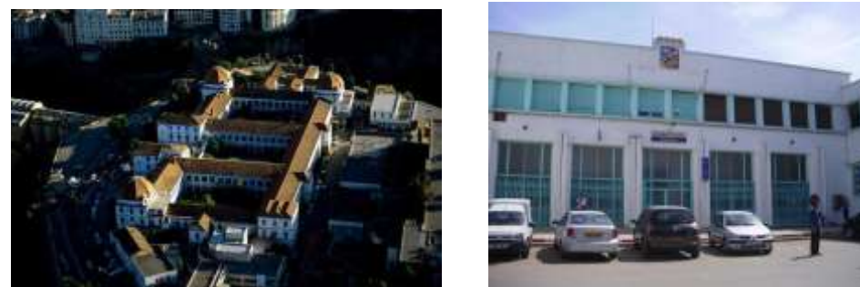
Architecture sociale (19 e -20 e siècle), les cours, les galeries et les grandes fenêtres, inspiration des médinas et exigences hygiénistes également. Lycée Lamoricière Oran, hôpital Baudens Oran, Lycée Bugeaud Alger, Petites sœurs des pauvres Oran, Hôpital Constantine, orphelinat de Beni-Messous, ( www.pinterest.com , consulté le 12 juin 2014).
