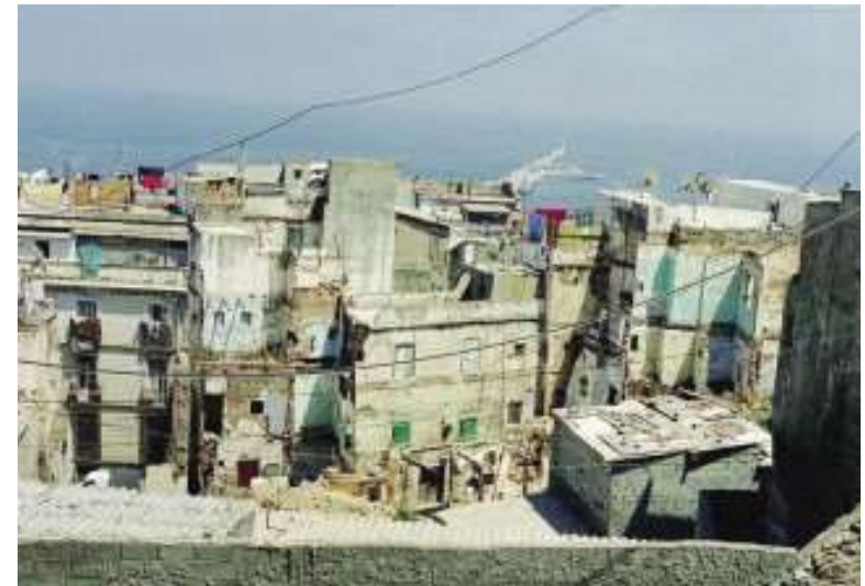
Le vieux bâti à Belouizdad Alger (www.dknews-dz.com, consulté le 31 mars 2016)
