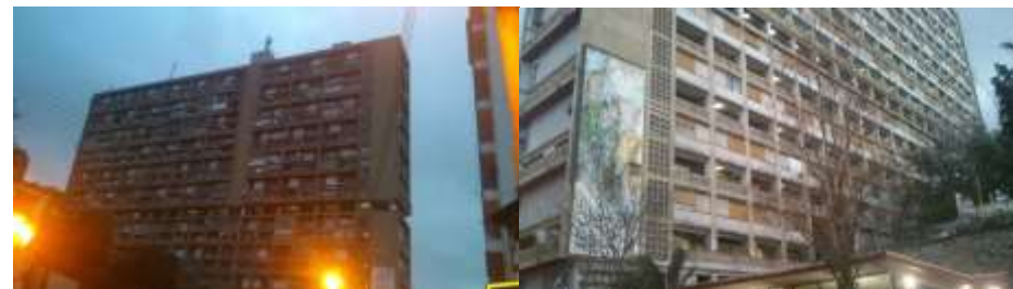
L'aéro-habitat, façades ouest et est (Mouaziz-Bouchentouf, février 2015)
