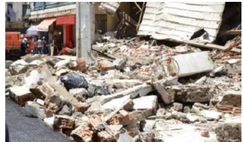
Effondrement d'un vieux bâtiment à Skikda (www.actualite-algerie.com, consulté le 10 septembre 2017)
