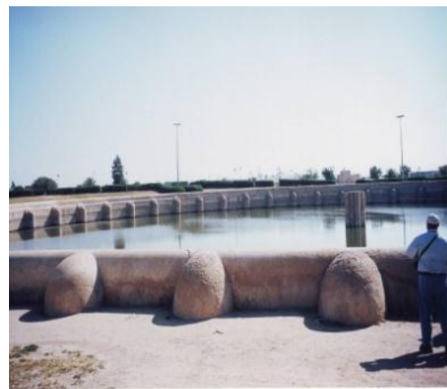
Figure 05: Les bassins de Kairouan. Source : Dalila Senhadji, 2005.
