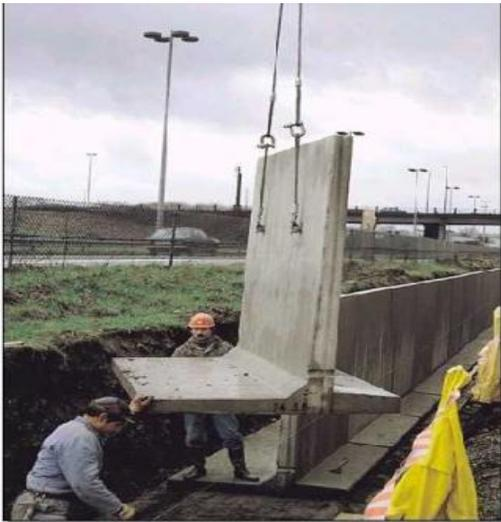
**Figure 1.18** Mur en BA préfabriqué [12]
