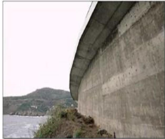
**Figure 1.19** Mur en BA avec encorbellement en tête [12].
