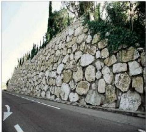
**Figure 1.3** Parement d'un mur en pierres jointoyées [3].
