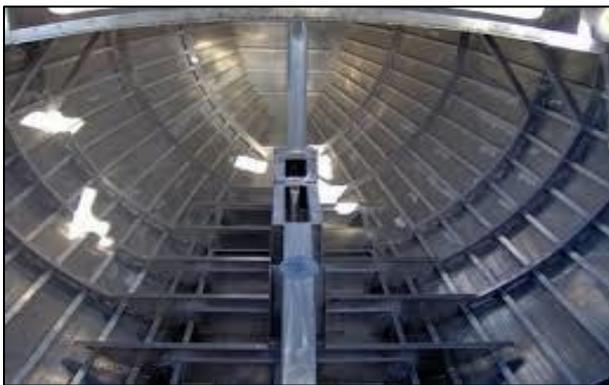
Figure I.12. Charpente en aluminium.
