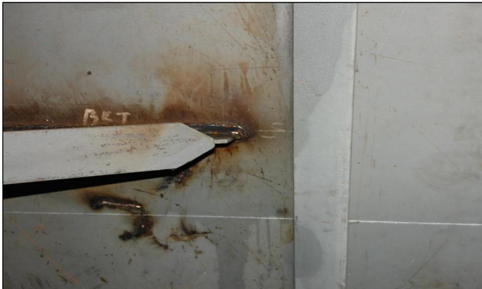
Figure IV.19. Coupage de la semelle supérieur de la varangue en chanfrein.
