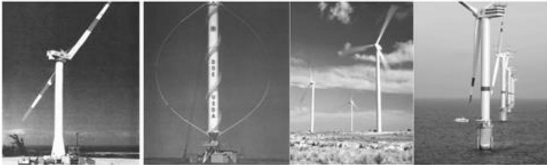
(a). HAWT 3.2MW DEO/NASA, 97.5, 1988, (b). VAWT 625kW, 34m de DOE/SNL, (c). Modèle-GE de 1.5MW rotor 70.5m et (d). modèle-5MW, rotor 126m en Belgique.
