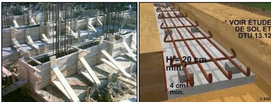
Figure 25 : Coffrage et ferrailage d'une semelle filante
