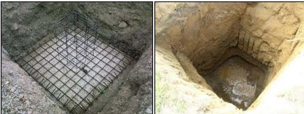
Figure 5 : Fouille en puits
