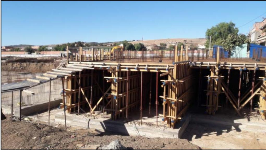
Figure 51 : Eléments de coffrage en bois (Coffrage tunnel)
