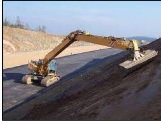
Figure 8 : Talutage en déblais
