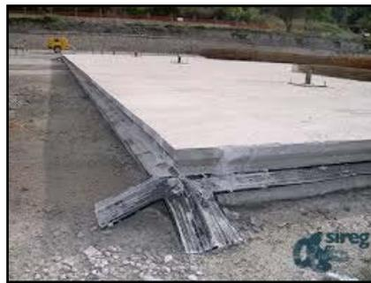
Figure 04 : Joint de construction
