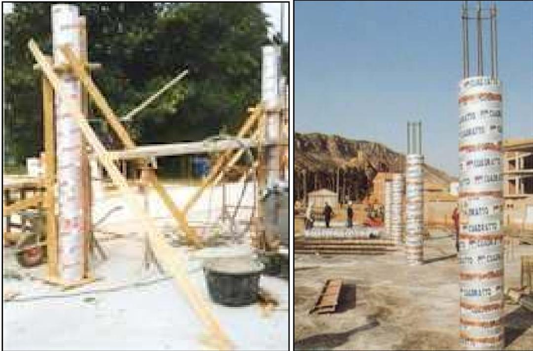
Figure 42 : Coffrage perdu en carton pour poteaux circulaires
