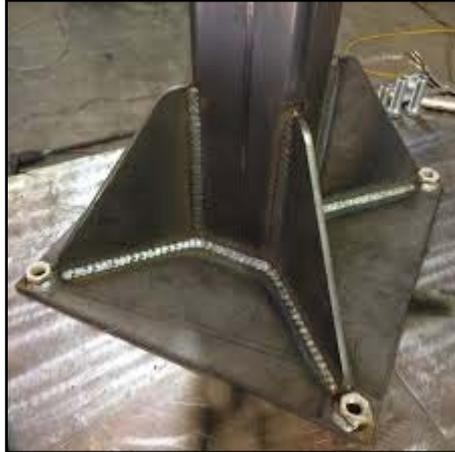
Figure 19 : Soudure de la base d'un poteau
