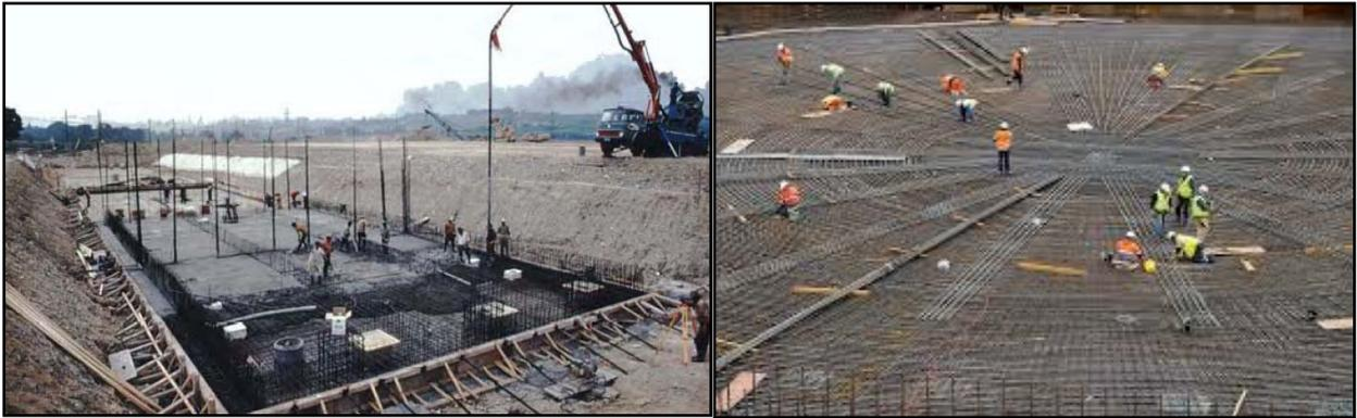
Figure 27 : Ferrailage et bétonnage de Radiers
