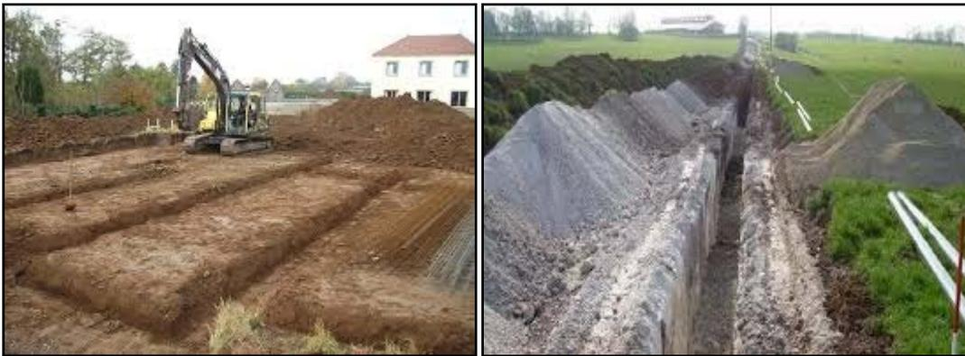
Figure 4 : Fouille en tranchée
