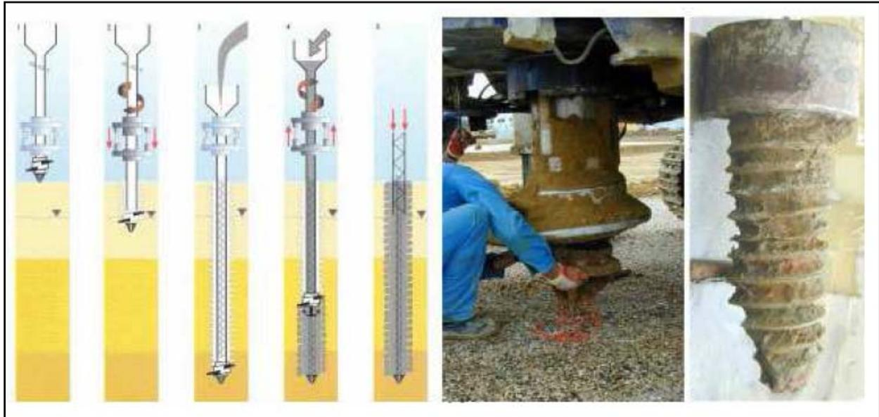
Figure 32 : Mise en place de pieu vissé moulé
