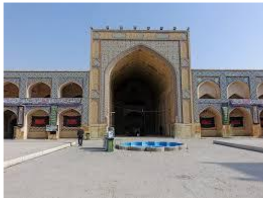
Fig N°86 mosquée d'Isphahan, iwan nord Source (Internet)
