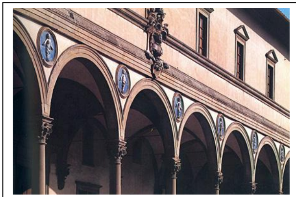
Fig N° 105 L'hôpital des Sains Innocents: Façade principale Source (Internet)
