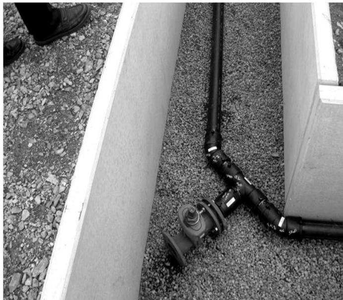
**Figure 5. 7. Raccordement en coude dans un réseau d'alimentation en eau potable (photo prise par Baba Hamed à la Souterraine – Office internationale de l'eau – Limoge, 2011)**
