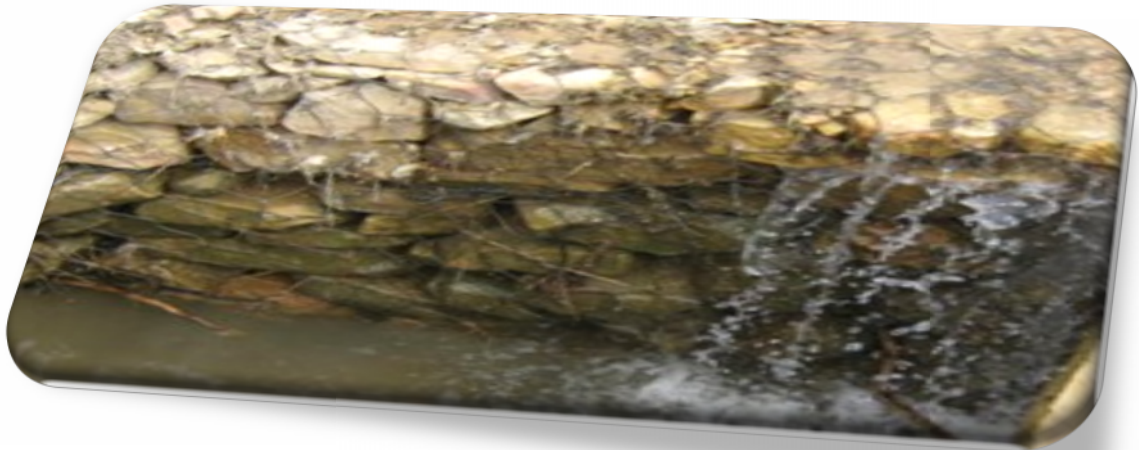
Photo (I.2) : Seuils de sédimentation en Gabions et en pierres sèches réalisés dans le bassin Versant du barrage BAKHADDA
