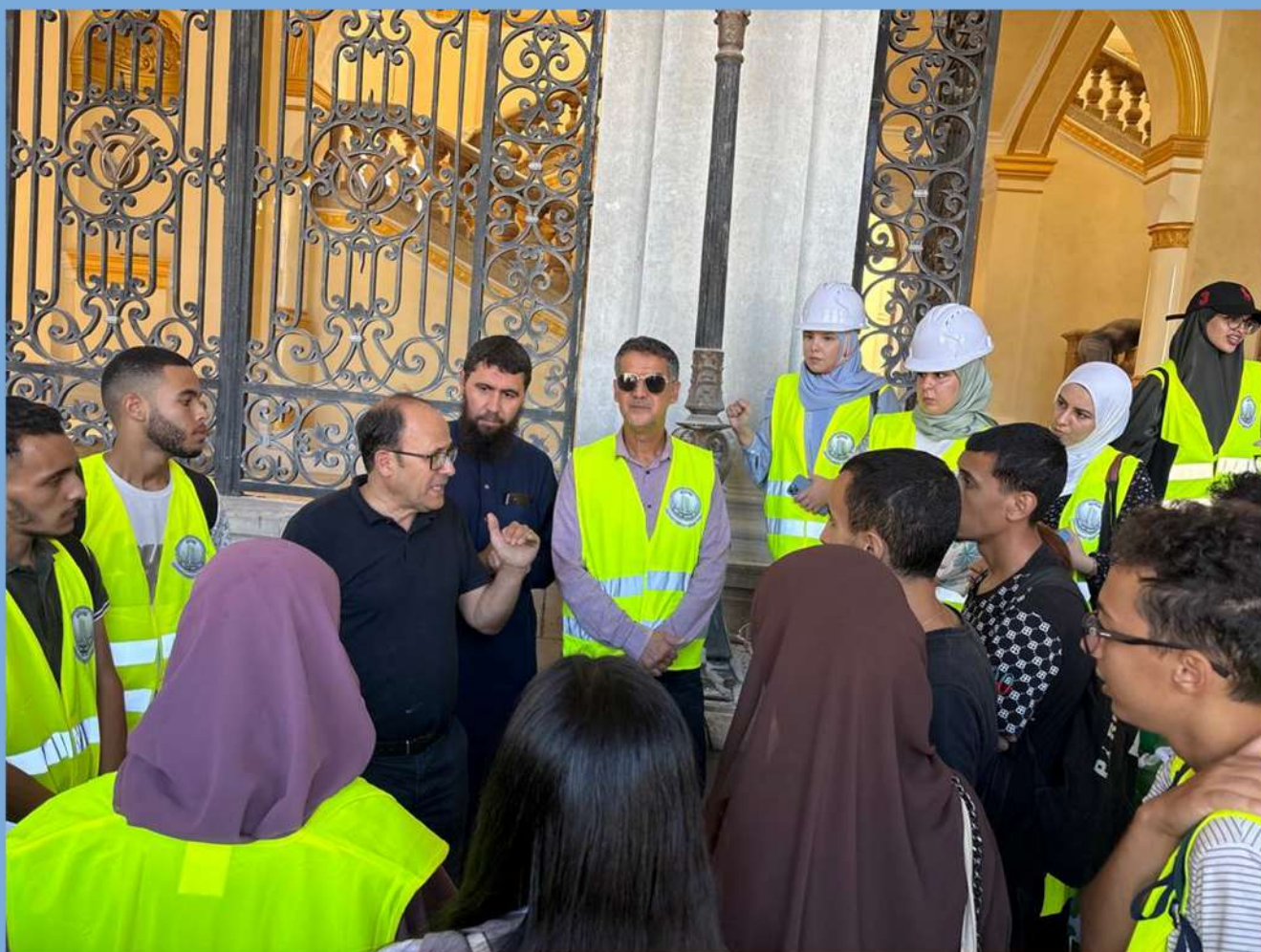
Sortie pédagogique des étudiants de Génie Civil de l'USTO-MB sur le chantier de réhabilitation de l'Hôtel de Ville d'Oran
